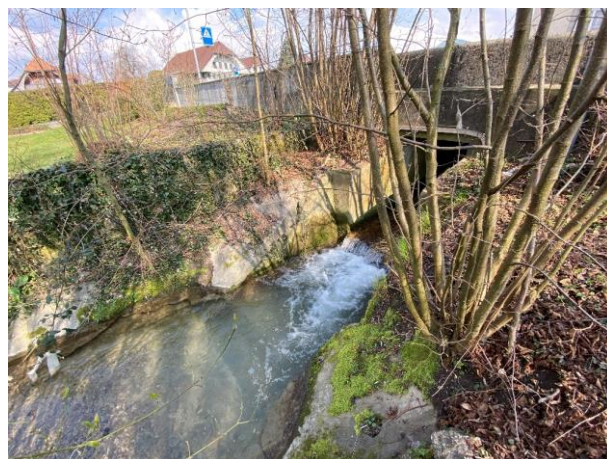
Foto 36: Ende der Eindolung unter Dorfstrasse. Blick gegen Fließrichtung
