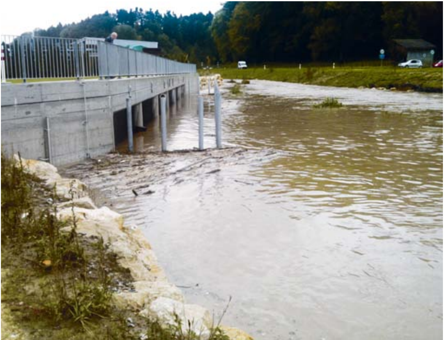
Der Stollen funktioniert: Das Einlaufbauwerk Leen im Oktober 2012
