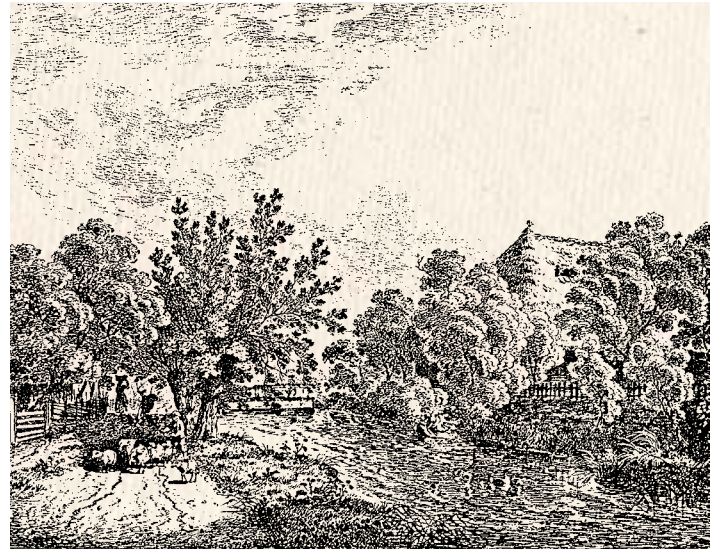
Der seinerzeitige Holzsteg beim Weissen Kreuz, links die Studengasse (in der Stauden), rechts das strohgedeckte Dach der Salzbütti (König-Stich um 1800/Privatbesitz).
