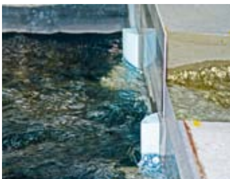
Das Wasser staut sich an der Blende und fliesst seitlich in einen Beruhigungsteich.
