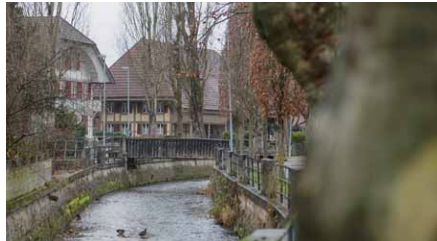
1 Die Brücke beim Herrengasse-Schulhaus. Carole Lauener/a
