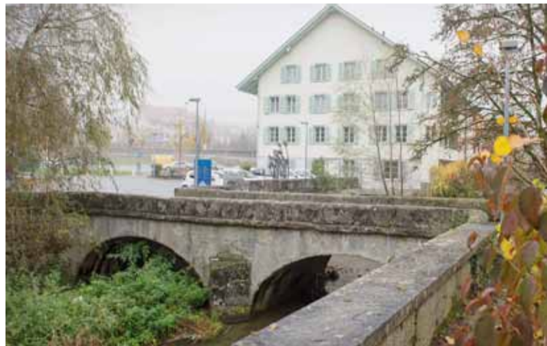
4 Die älteste Brücke von Lyss bei der Kirchgasse. Peter Samuel Jaggi/a
