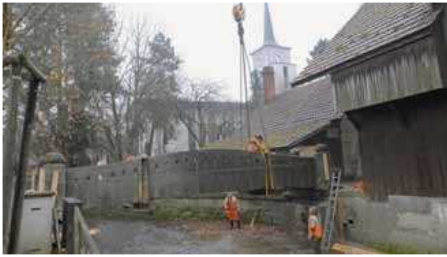
Die Wüthrichbrücke wird mit einem Pneukran um 60 Zentimeter angehoben
