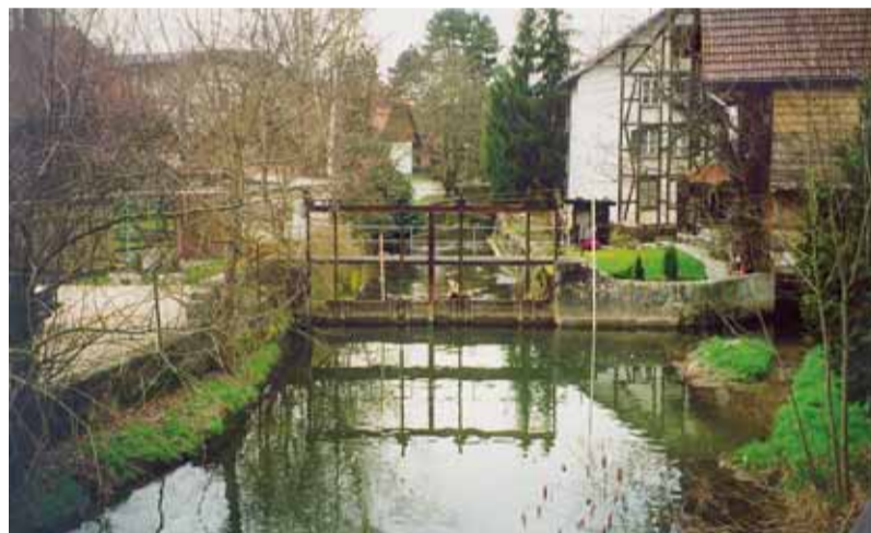
5 Das alte Wehr bei der Unteren Mühle wird wieder aufgebaut. zvg
